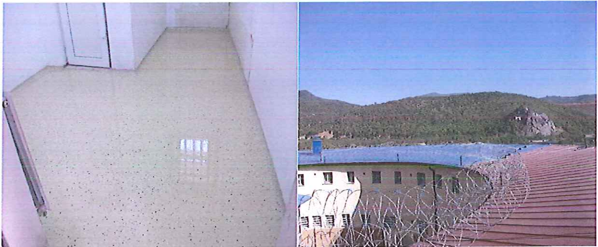
“Renovimi dhe izolimi i kulmit ne Q.P.Mitrovicë “ Është bërë izolimi i kulmit dhe punimi i dyshemeve me epox.
